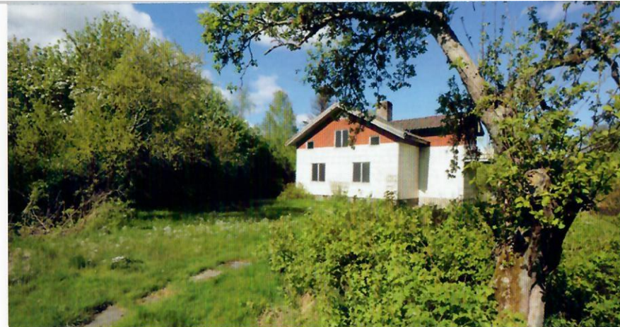
Bostadshuset som byggdes i slutet av 1800-talet när Albin och Sabina övertagit fastigheten. Bilden är tagen 2009.
